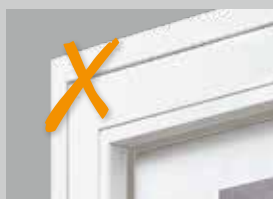
Házbejárat ajtók belső nézete: más gyártóknál látható a szárnyprofil és az üvegezőléc
